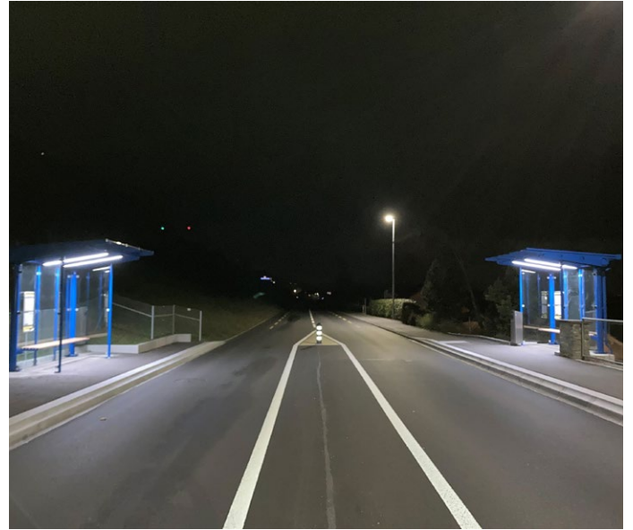
Beleuchtete Haltestellen Teller bei Nacht am Ortsausgang von Einigen.
